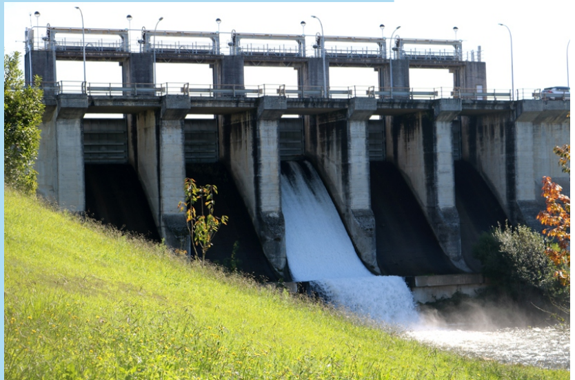
Encoro de Cecebre. Foi construído entre 1975 e 1976 para fornecer de auga á Coruña. Aproveita as augas dos ríos Mero e Barcés.
