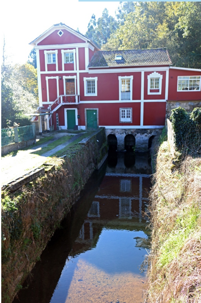
Muíño de Peirao (Bribes). Construído a finais do século XVIII. Aproveita as augas do río Mero para accionar unha roda hidráulica vertical (acea ou bruvia) e dúas rodas
